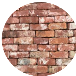
Brique de réemploi sur le soubassement
