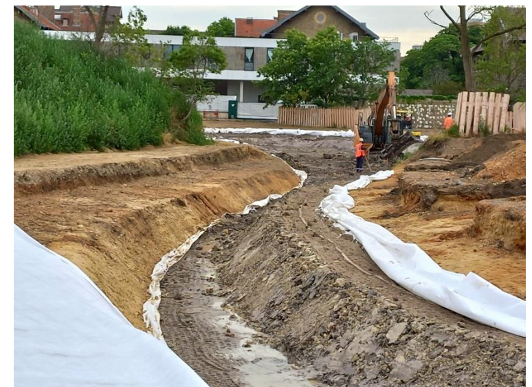
Aménagement du jardin et du bassin
