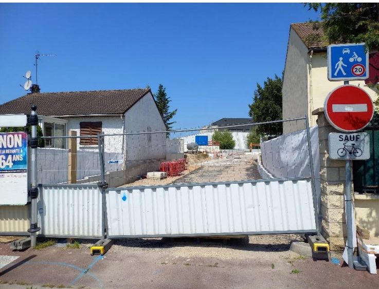
Elargissement de la rue des Potagers (prolongement rue des Ormes)
