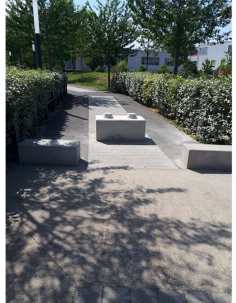
Blocs béton scellés au sol (S1 2022)
