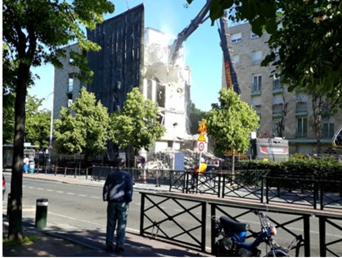
Démolition du 99 avenue Picasso (livrée septembre 2021)
