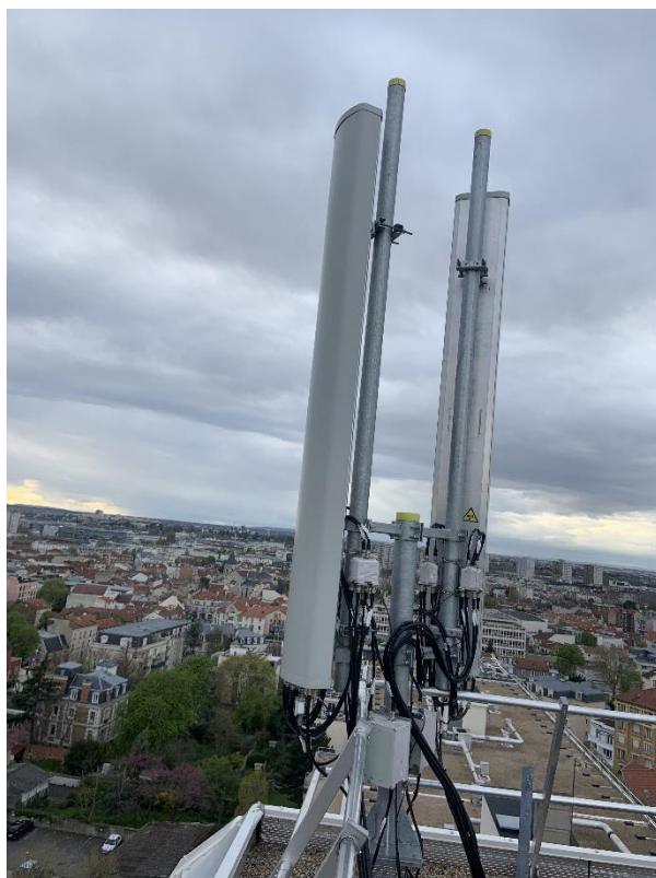
Vue de la terrasse S1 avant travaux
