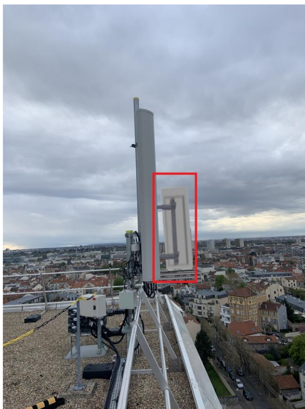
Vue de la terrasse S0 après travaux
