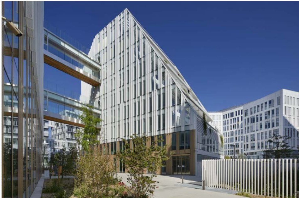
Le cheminement déjà créé au sein de l'opération Origine
