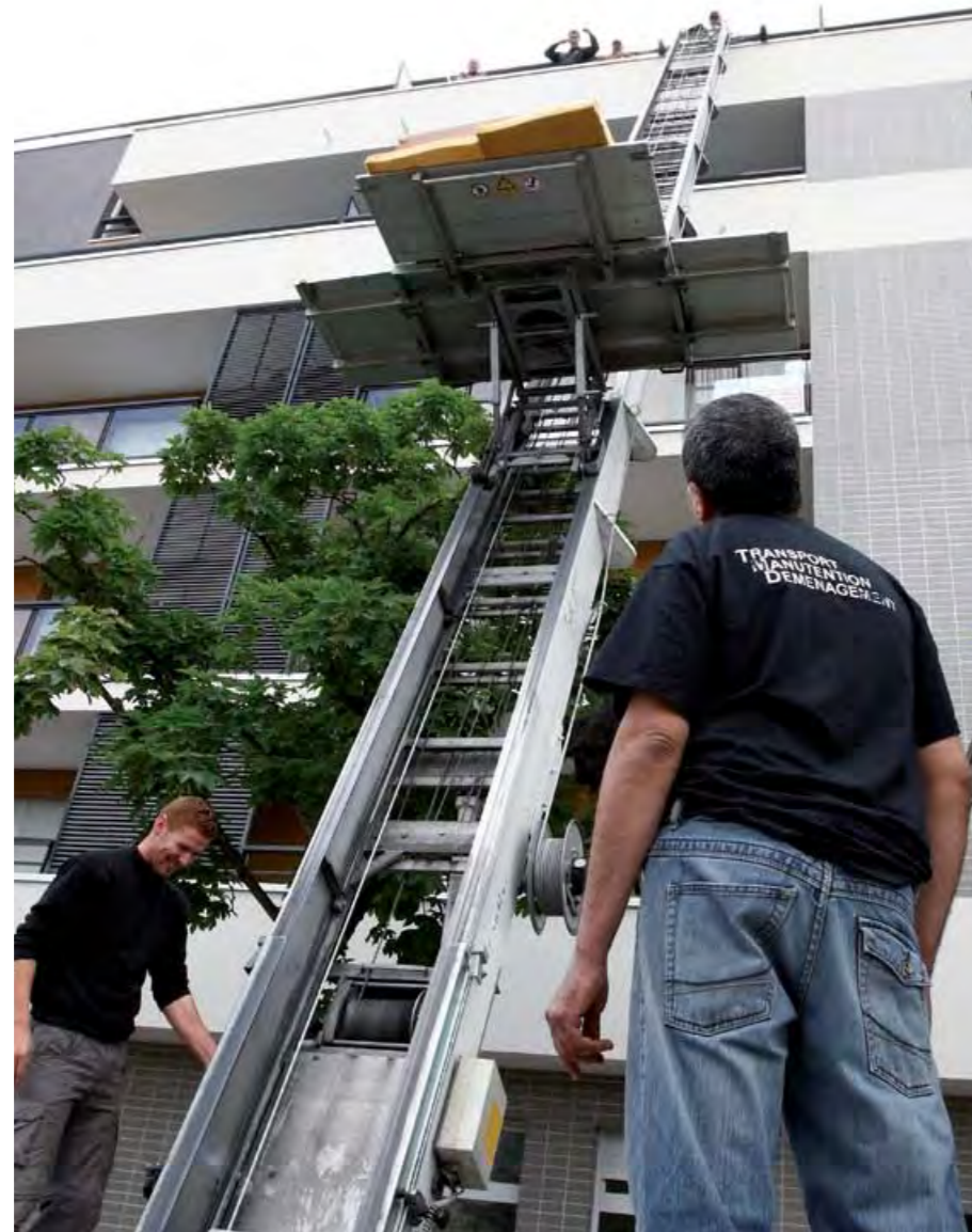
Juin 2011, les 1 ers habitants du nouvel immeuble de logements sociaux construit avenue de la République emménagent
