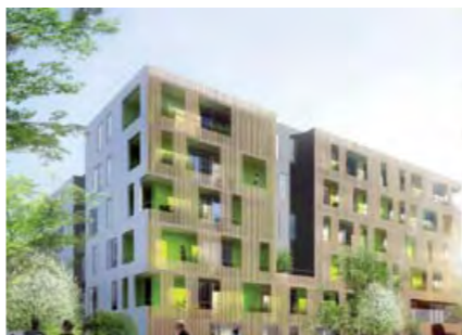
Perspective de la 2 e opération immobilière, rue de Strasbourg
